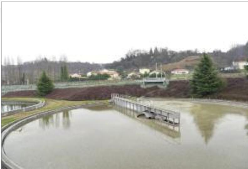
clarificateur(décanteur secondaire) fin du traitement des eaux
